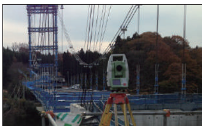
ケーブルエレクション工法
