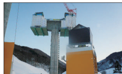
張り出し工法
