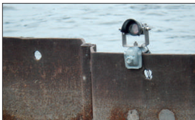
山留材頭部の変位を観測
