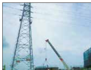
▲高圧線・橋梁との離隔管理
