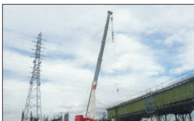
高圧線・橋脚との離隔管理
