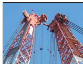
▲近接する重機の接触管理
