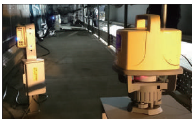
アンダーピニング工法での高さ管理
