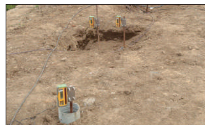
地盤の沈下・隆起計測
